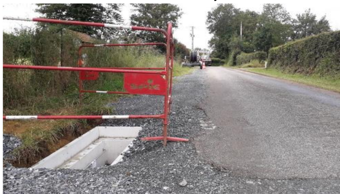
Enfouissement à la Grande Planche
