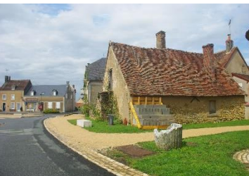
La maison Pennetier avant travaux
