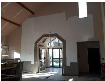
Travaux salle des fêtes
