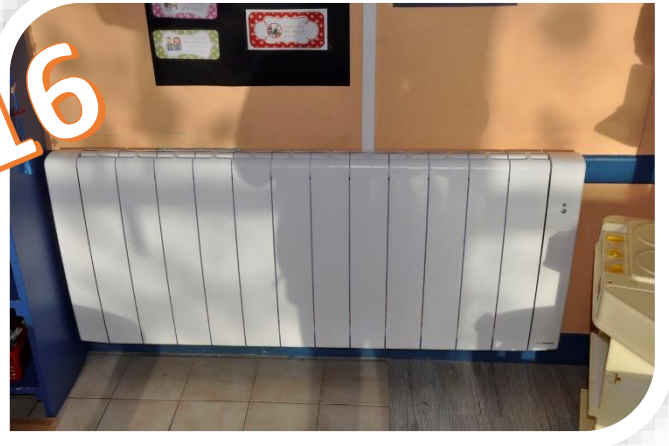
Chauffage électrique école
