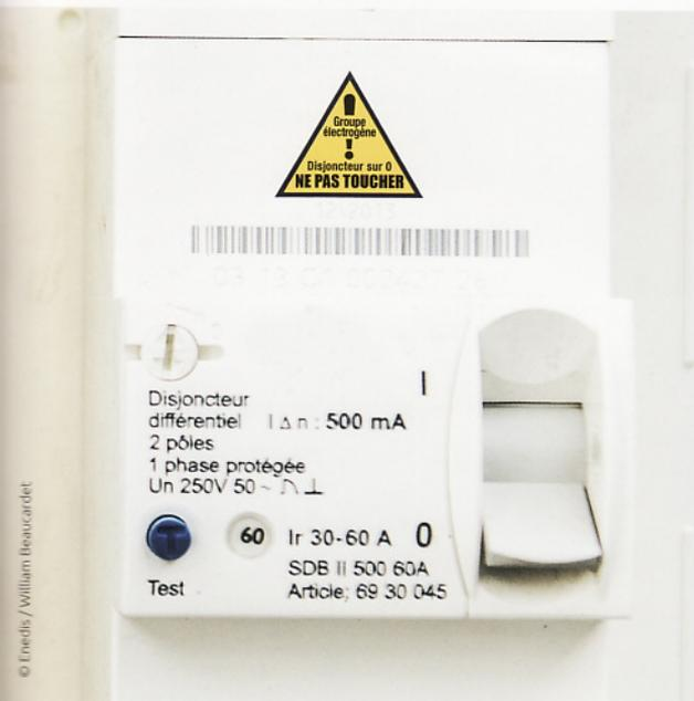
Cet autocollant repositionnable est à placer sur votre disjoncteur avant de brancher votre groupe électrogène à votre installation électrique.
